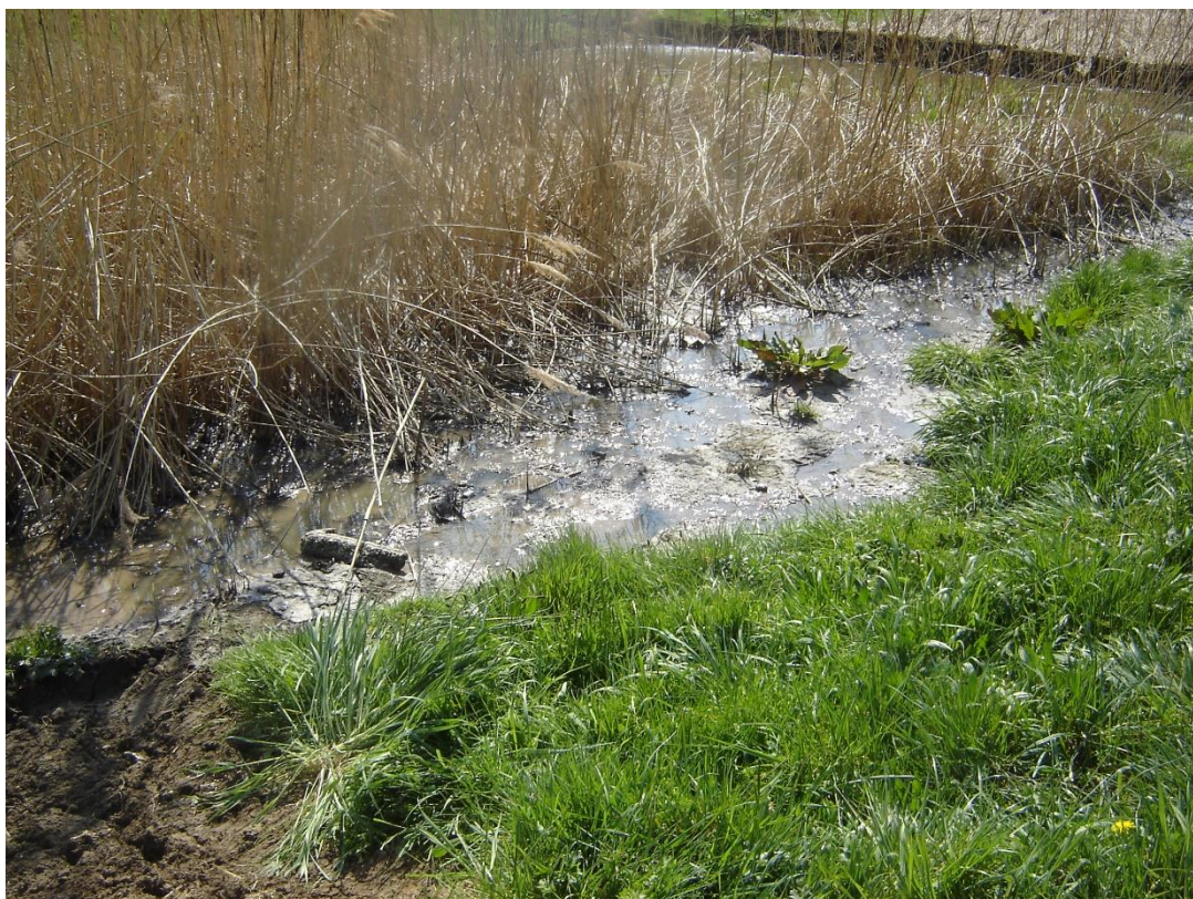
Etat actuel de la station de lagunage.
